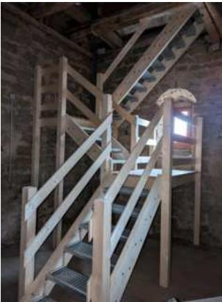
die Glockenebene mit zwei Podesten hinein geplant und installiert. Ab sofort kann der Turm also wieder gefahrlos (zB beim Aufhängen der Kirchenfahne oder für Glockenreparaturen) begangen werden!
